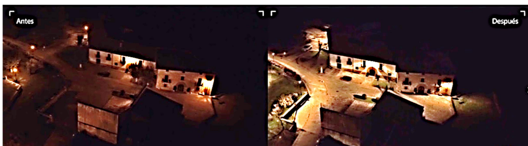
Concejo de Ustarroz antes y después de la actuación Foto cortesía de ATP Iluminación
