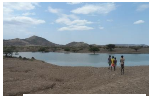
Presa de arena realizada por la MCSPA
