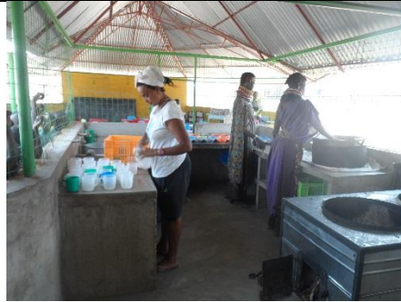
Cocina finalizada (unidad nutricional Kokuselei)
