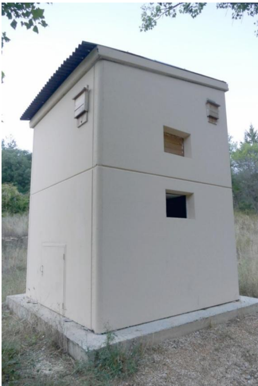
Figura 7. Caseta-refugio de Acedo. Se observa el tejado sobre elevado de material bituminoso, la pintura termoaislante en las paredes y dos cajas-refugio en las paredes.
